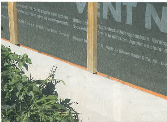
La barrière physicochimique contre les termites est une bande orangée déroulée sur le surbot entre la maçonnerie des fondations et la structure bois des murs. Cette protection doit être continue et mise en œuvre également dans les passages de réseaux ou les réserves dans la dalle.
