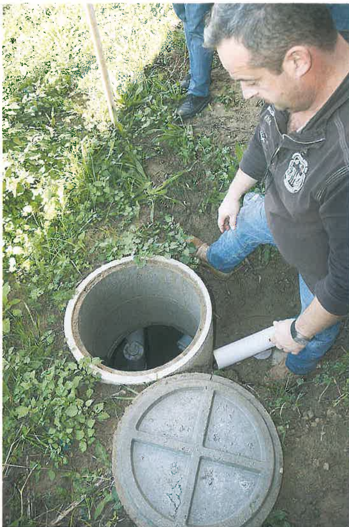
Dans un terrain avec remontée d'eau, la cuve d'eau pluviale en béton présente un avantage par son poids. Il n'est pas besoin de la sangler comme une cuve plastique. Il suffit de bétonner le fond de la fouille pour la coller. Le couvercle en voûte supporte une épaisseur de 80 cm de remblai.
